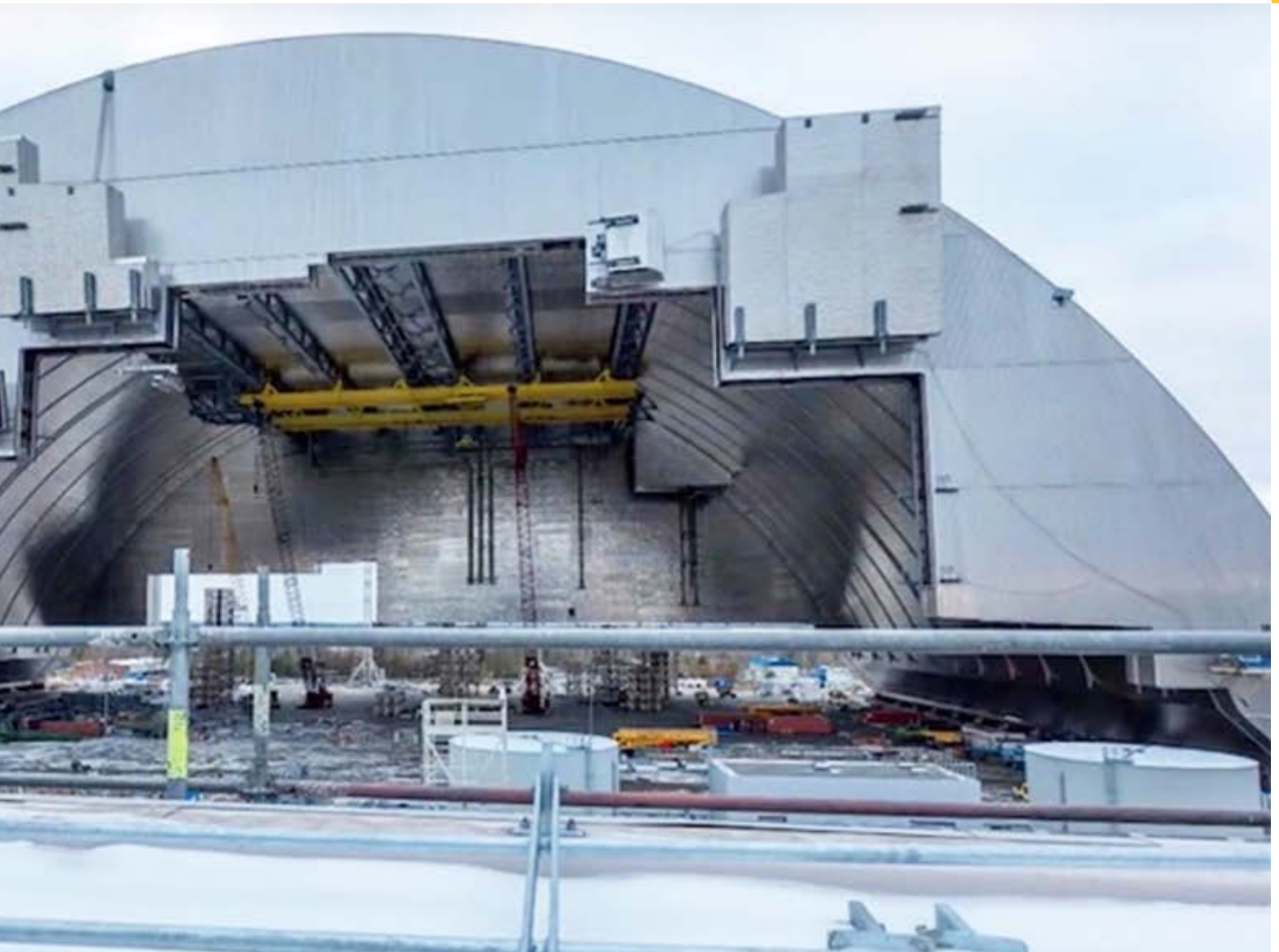
Figura 8 Instalación de la estructura de confinamiento del reactor no.4 de Chernóbil. Tomada de [18].
